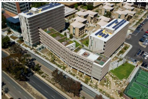
Figura 1 - Conjunto habitacional Charles David Keeling Apartments, Califórnia
