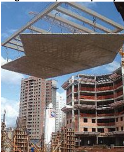
Figura 18 - Lçamento pré-laje
